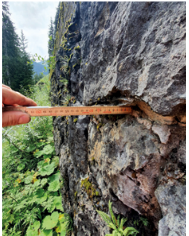
Detail Versatz bis zu 10 cm in horizontaler Mauerwerksfuge.
