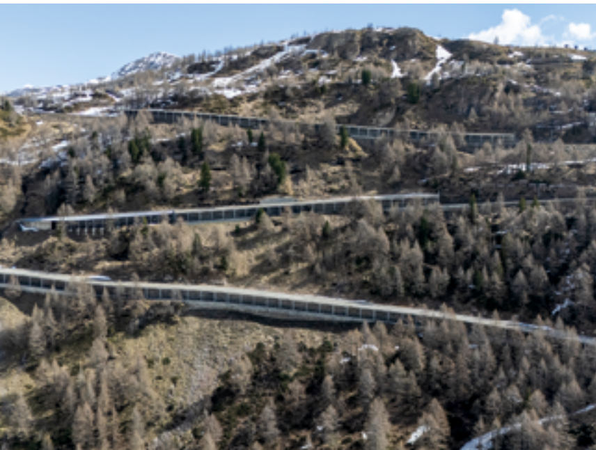
Bernina-Südrampe von oben nach unten: Galerie Grüm, Galerie Palü sopra, Galerie Palü sotto.
