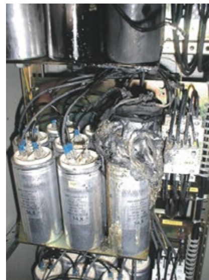
Abb.: Zerstörte Kondensatoren durch Oberschwingungen
