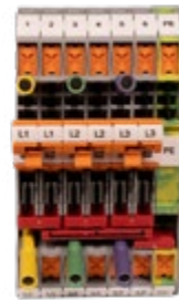
Abb.: Stromwandlerklemmleiste
